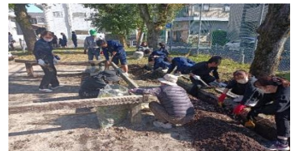
*側溝の泥をすくい取り*
